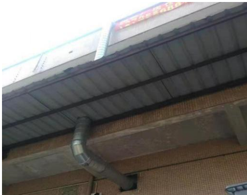
模头煅烧房间，空间换气收集废气并入主管道
