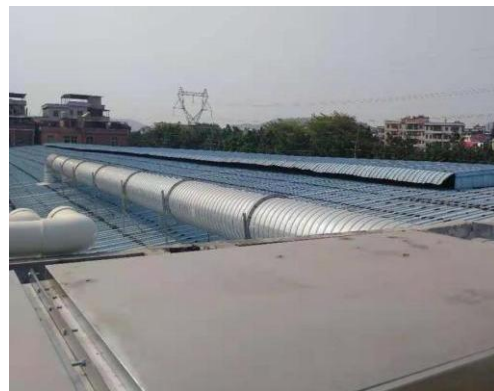
模头煅烧房间，空间换气收集废气并入主管道
